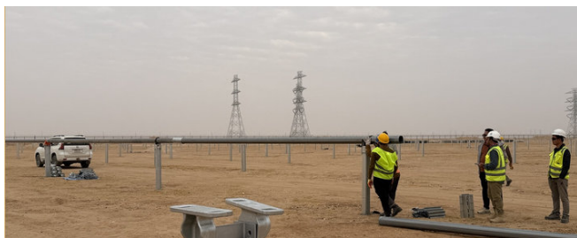
支架横梁安装与检查
