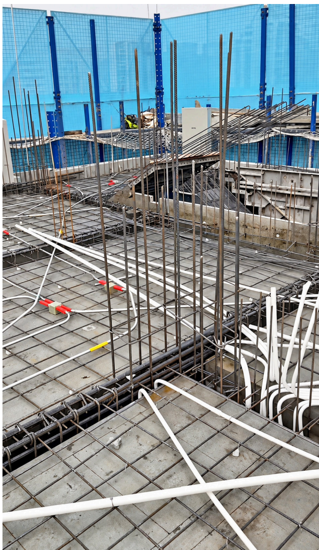
结构施工阶段的管线预埋
