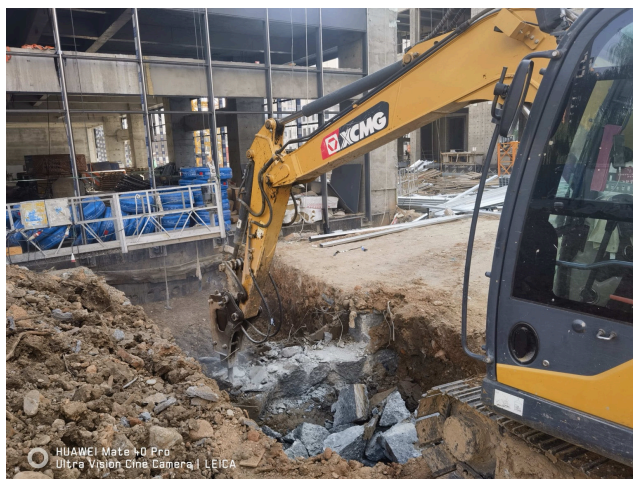
土方作业及机械破碎施工
