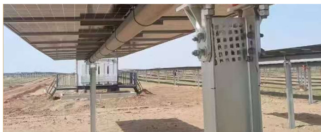
光伏支架结构细节
