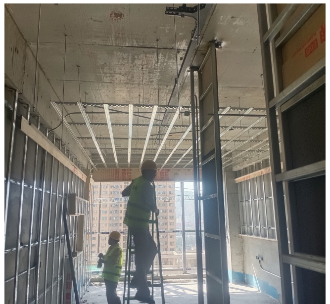
吊顶骨架施工
