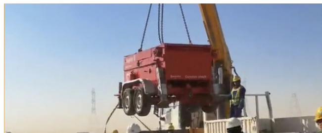
施工设备吊装与转场
