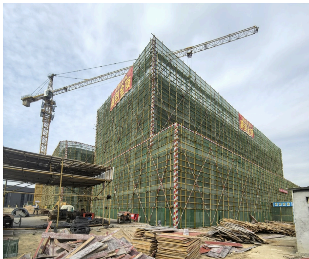
主体结构及脚手架施工
