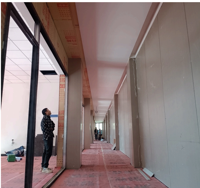
走廊装修现场
