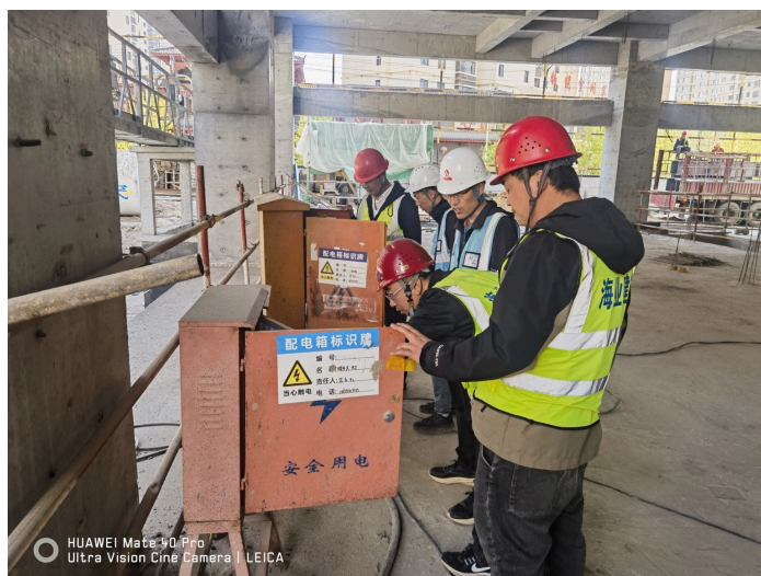
现场设备检查
