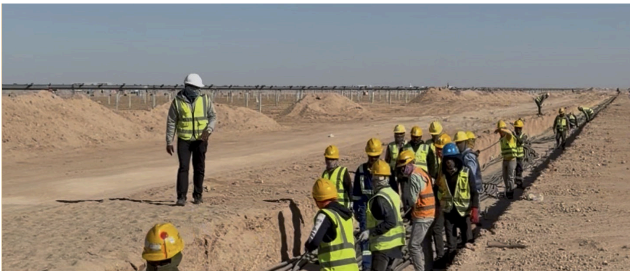
电缆敷设施工与班组协调
