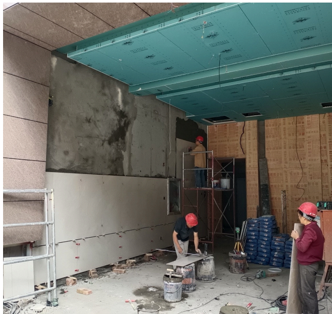
室内装修施工
