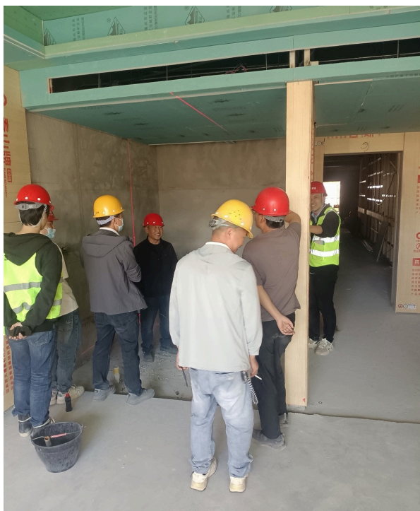
室内施工检查
