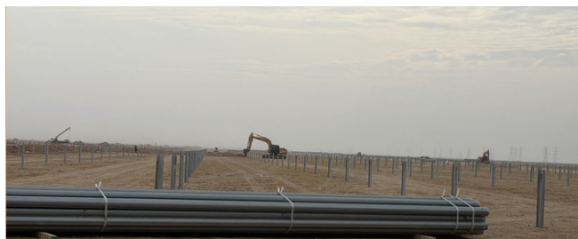
桩材及结构材料准备
