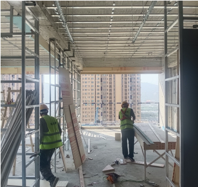
室内施工现场
