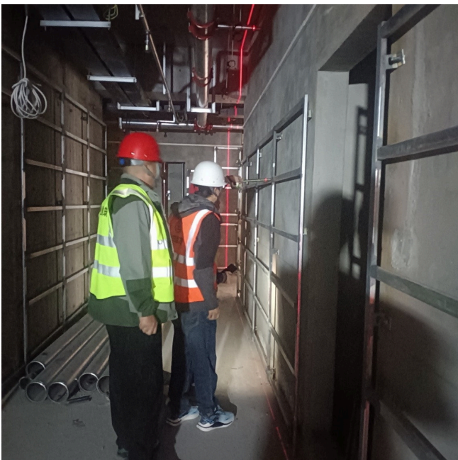
管线施工现场检查
