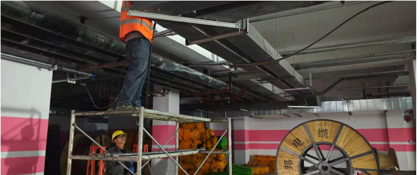
管线安装作业
