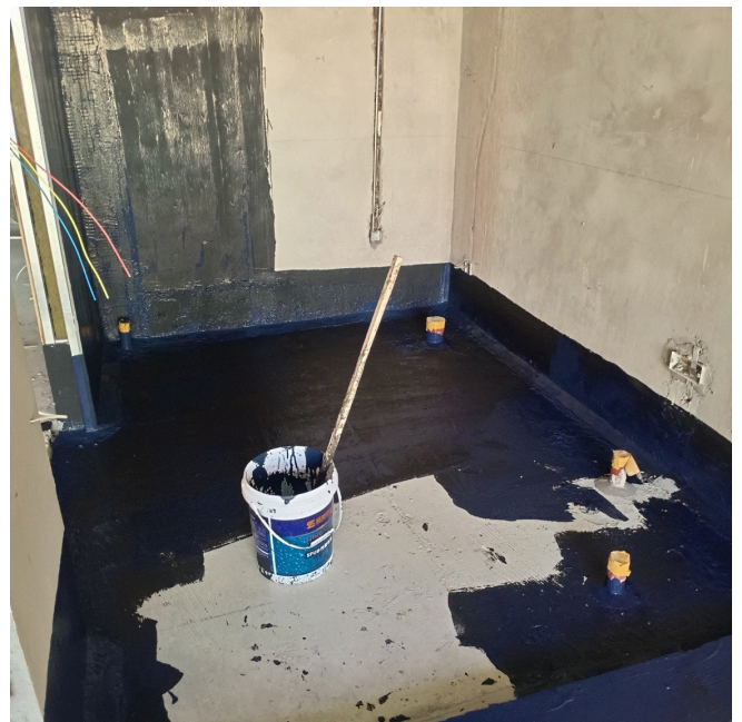
室内防水施工
