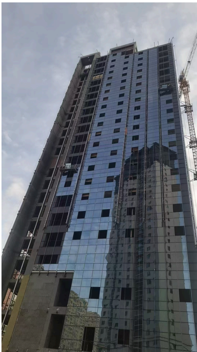
楼体外立面及幕墙施工
