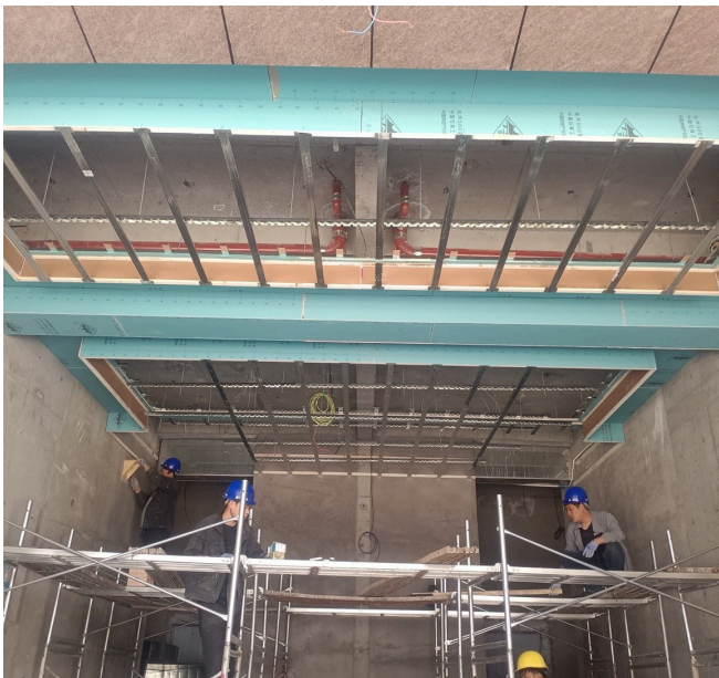
吊顶安装施工
