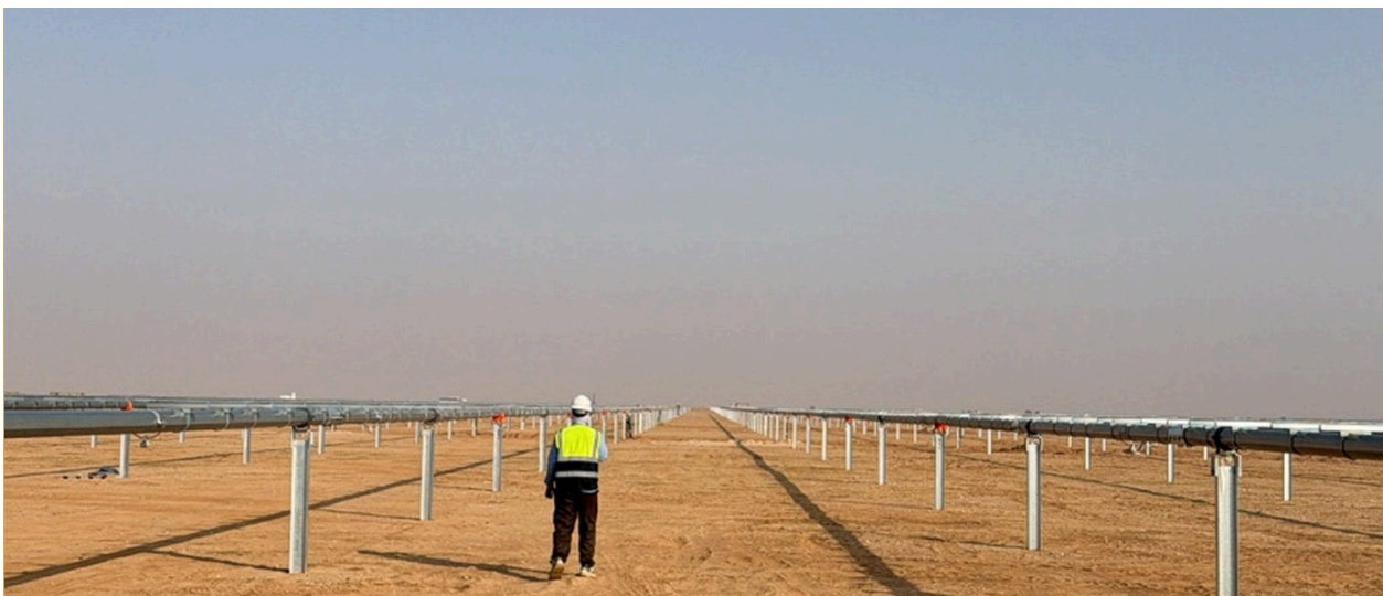
光伏支架施工现场
