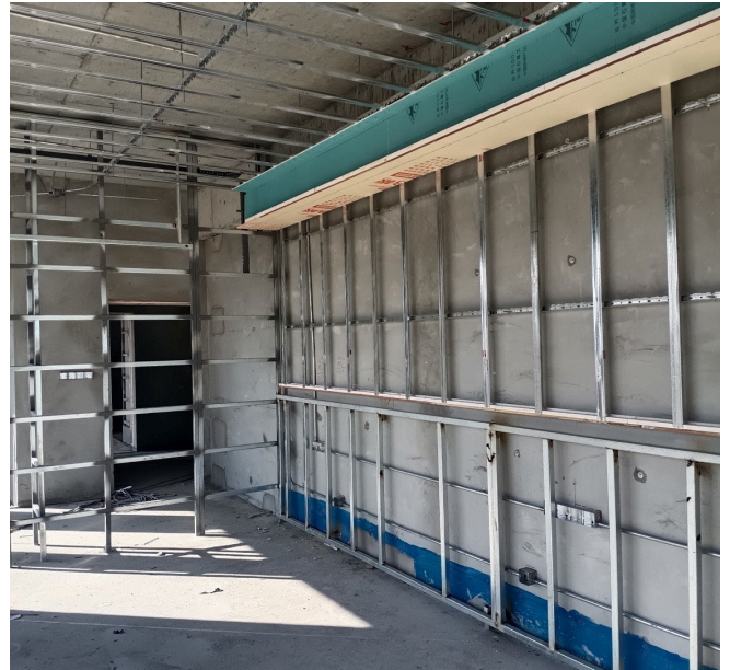
隔墙骨架安装
