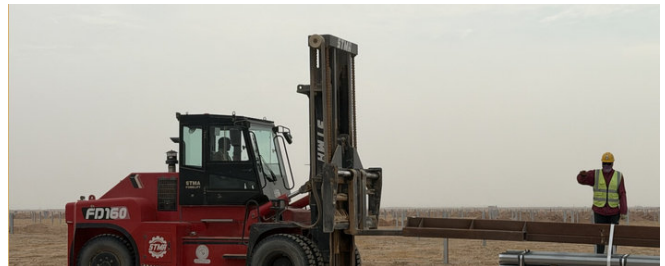
现场材料搬运与转运
